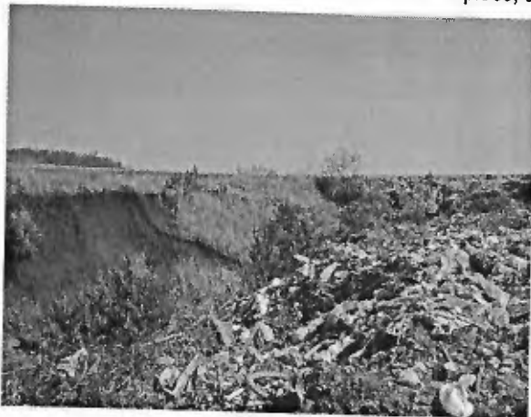
FIGURA 18: RESÍDUOS DA CONSTRUÇÃO CIVIL EM ENCOSTAS
