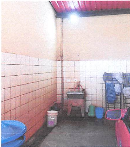
Revestimento do lavatório de veículos, que será lavado e receberá pintura.
