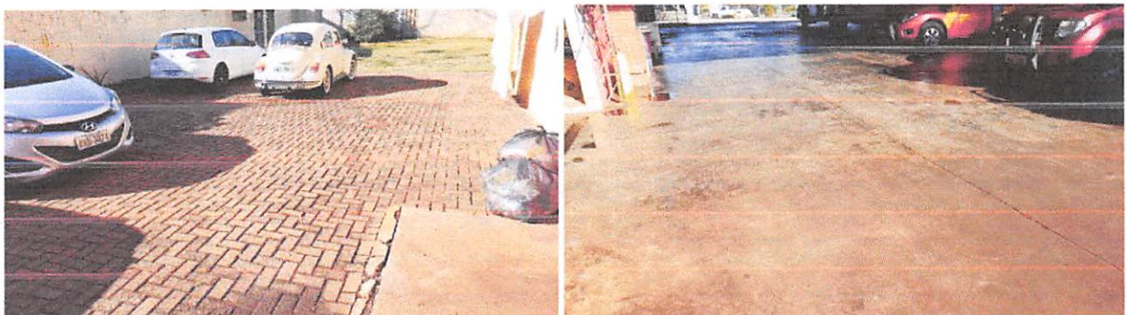
Parte do piso do pátio e calçamentos que receberão pintura.
