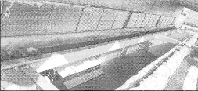
REMOÇÃO DE TELHAS FIBROCIMENTO
