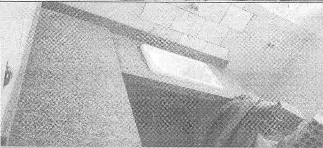
EXECUÇÃO DE BANCADA
