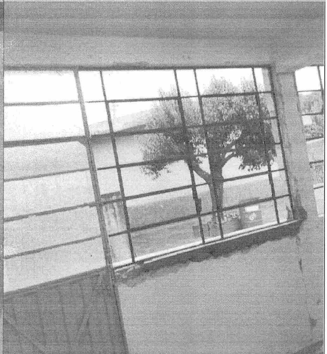
SUBSTITUIÇÃO DE ESQUADRIAS
