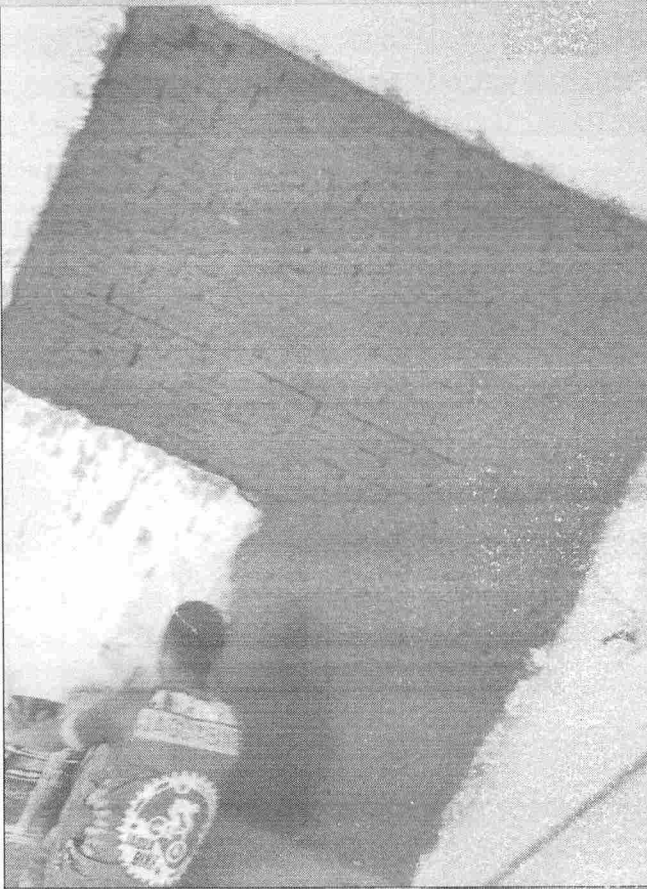
EXECUÇÃO DE ALVENARIA
