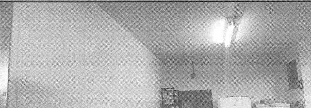
EXECUÇÃO DE PONTOS ELÉTRICOS
