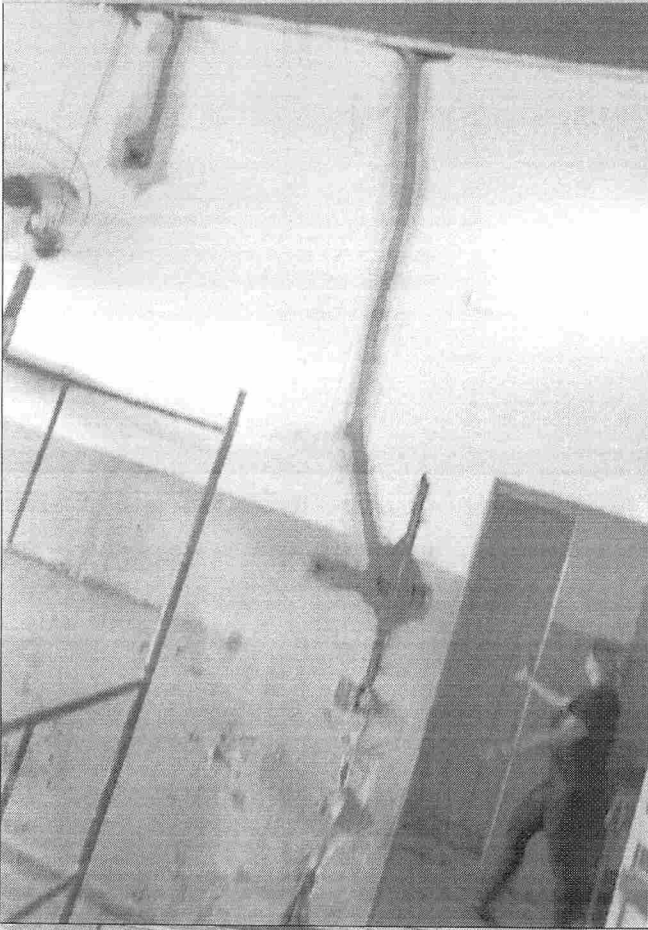
EXECUÇÃO DE PONTOS ELÉTRICOS
