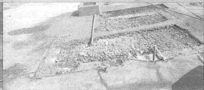
EXECUÇÃO DE CONTRAPISO EM CISTERNA
