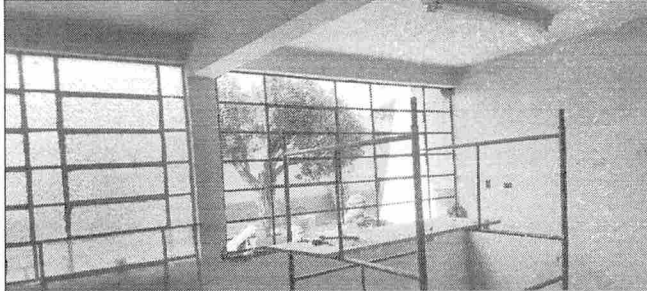
SUBSTITUIÇÃO DE ESQUADRIAS
