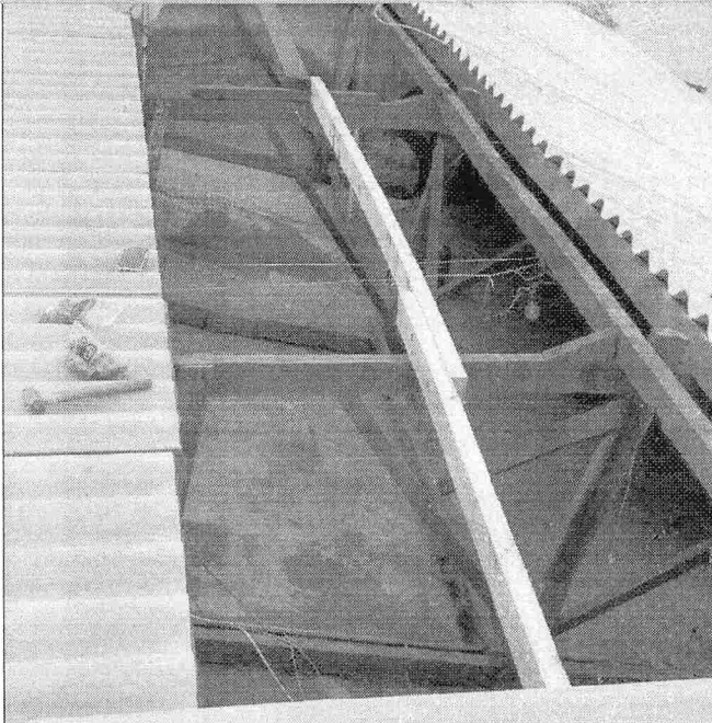
SUBSTITUIÇÃO DE TERÇA
