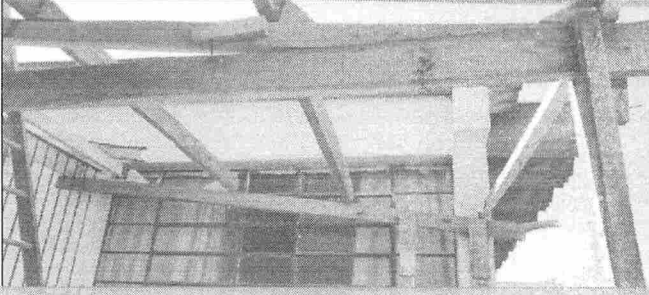
SUBSTITUIÇÃO DE TERÇAS
