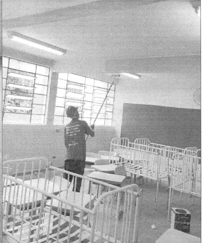
EXECUÇÃO DE PINTURA
