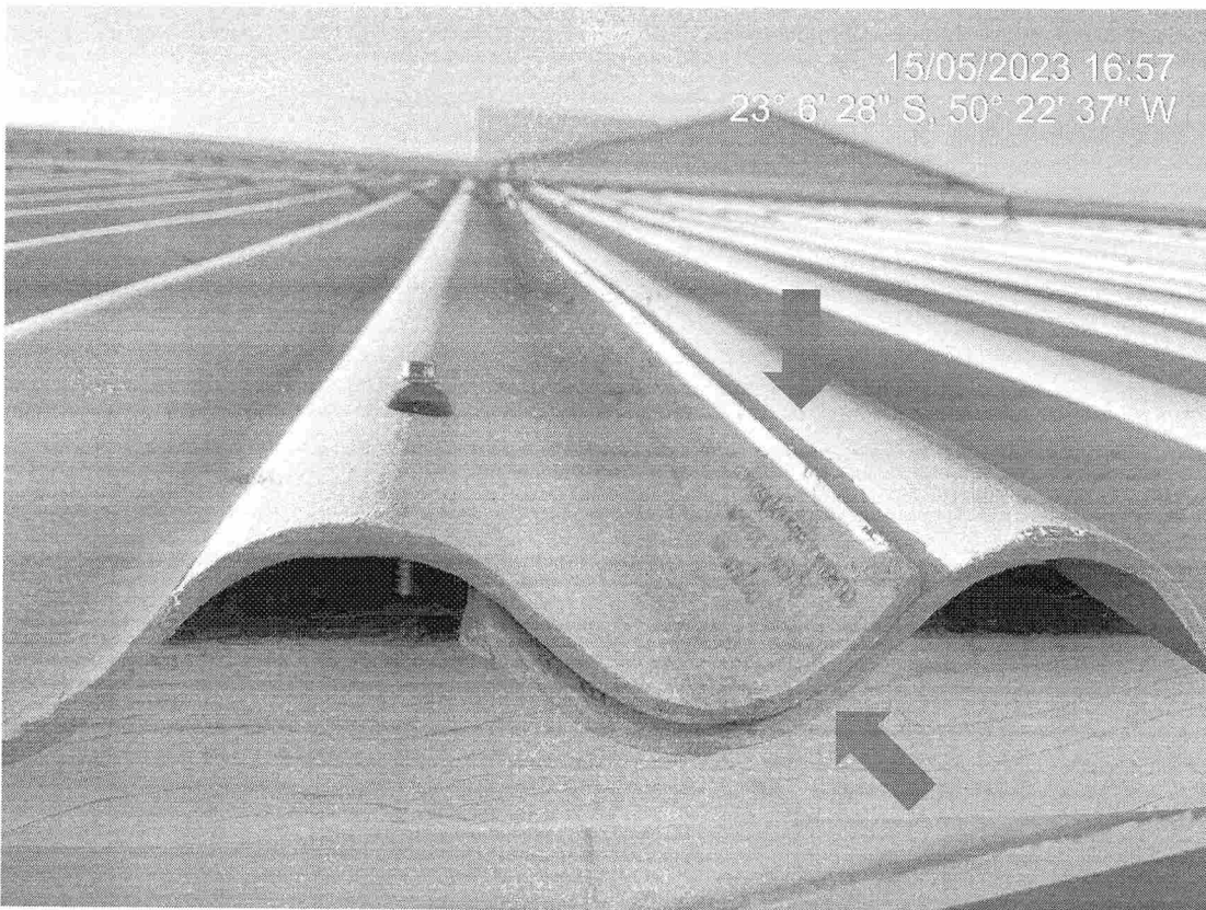
Figura 35 - Telha de fibrocimento com transpasse lateral de 1/4 de volta e com onda voltada para cima
