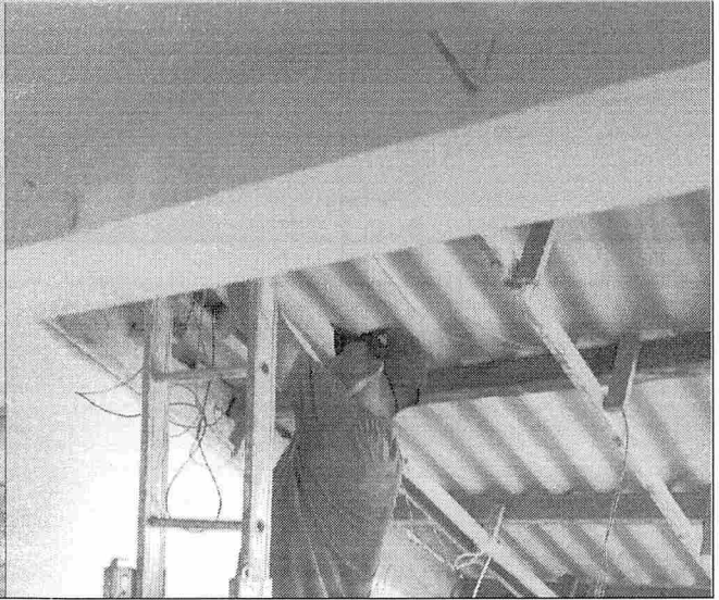
EXECUÇÃO DE PONTOS ELÉTRICOS
