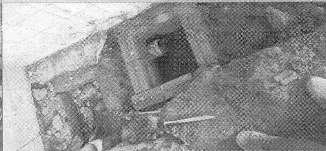
EXECUÇÃO DE CAIXA DE PASSAGEM
