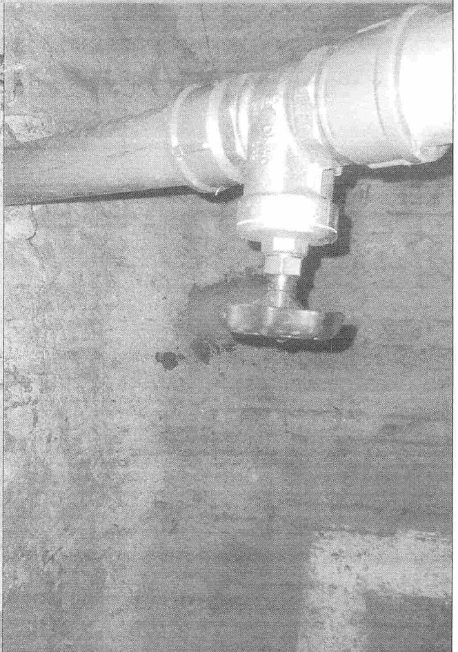
SUBSTITUIÇÃO DE REGISTRO
