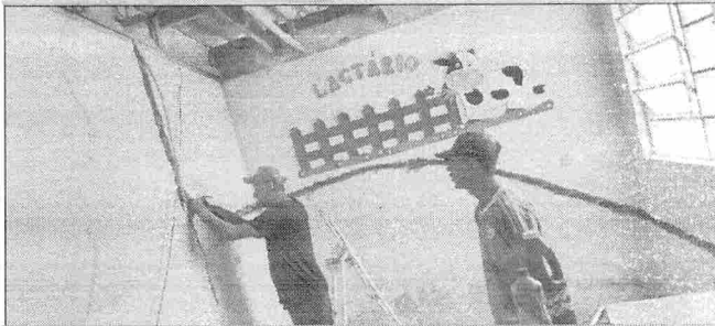
EXECUÇÃO DE PONTOS ELÉTRICOS
