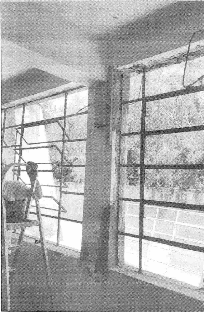
SUBSTITUIÇÃO DE ESQUADRIAS
