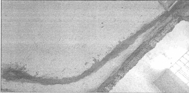
EXECUÇÃO DE PONTOS ELÉTRICOS
