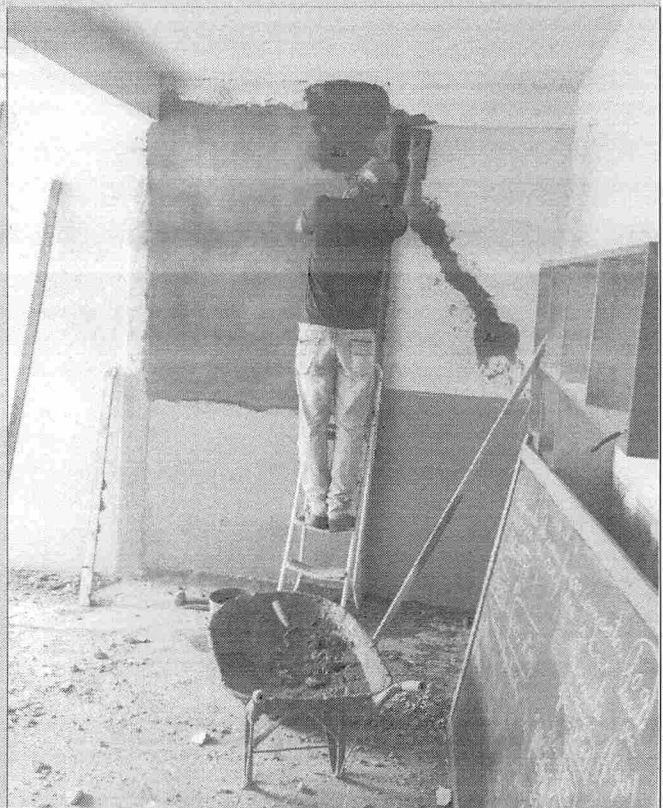
EXECUÇÃO DE PONTOS ELÉTRICOS
