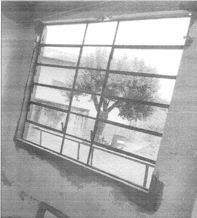
SUBSTITUIÇÃO DE ESQUADRIAS
