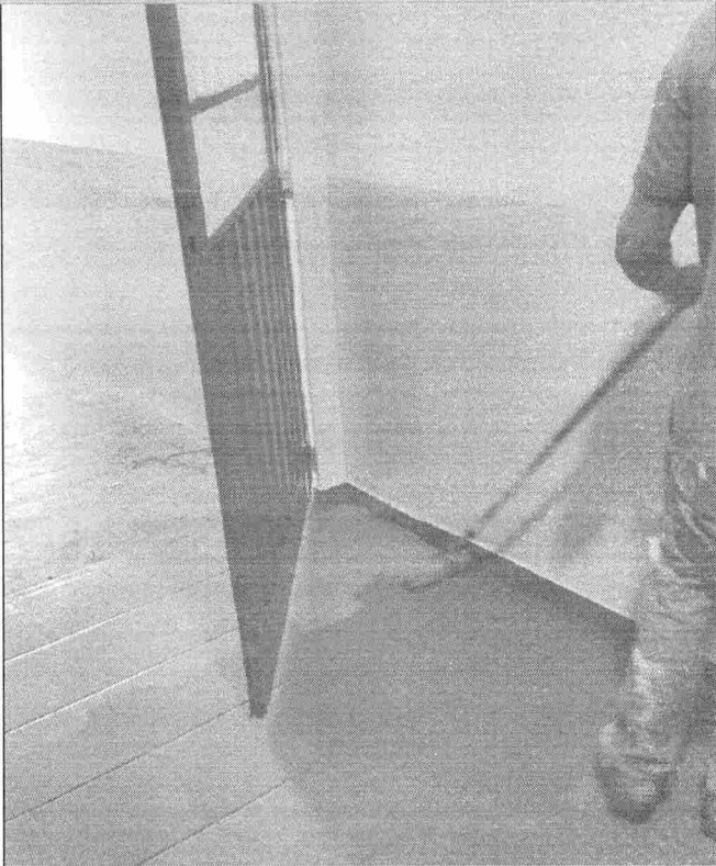
EXECUÇÃO DE PINTURA DO PISO
