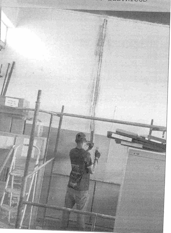
EXECUÇÃO DE PONTOS ELÉTRICOS
