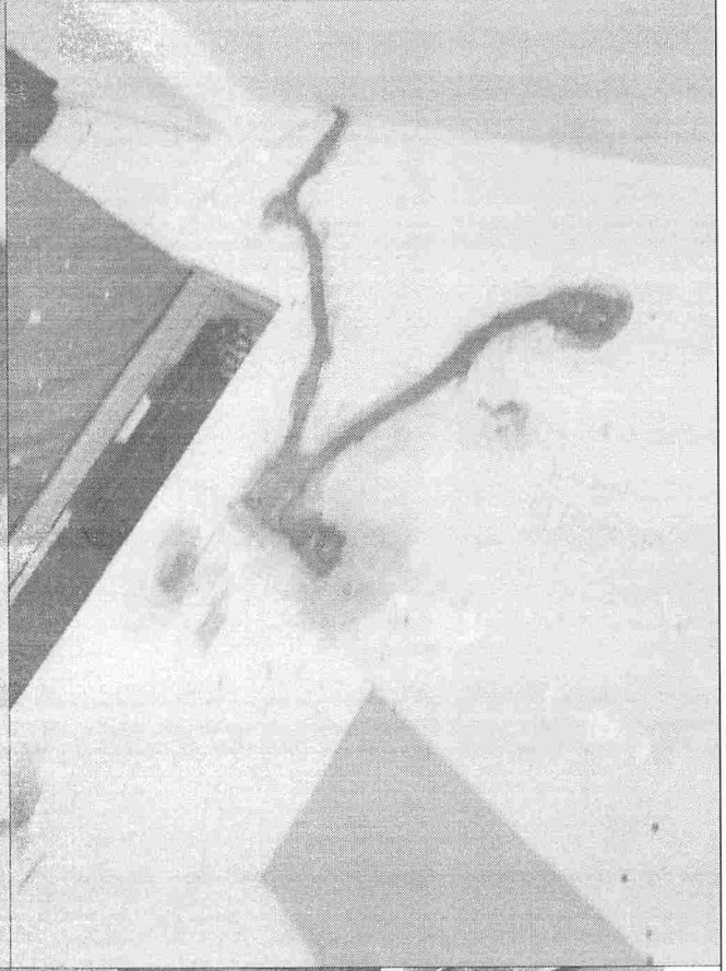
CHUMBAMENTO DE ELETRODUTOS
