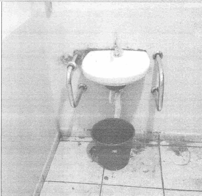
INSTALAÇÃO DE BARRAS PNE
