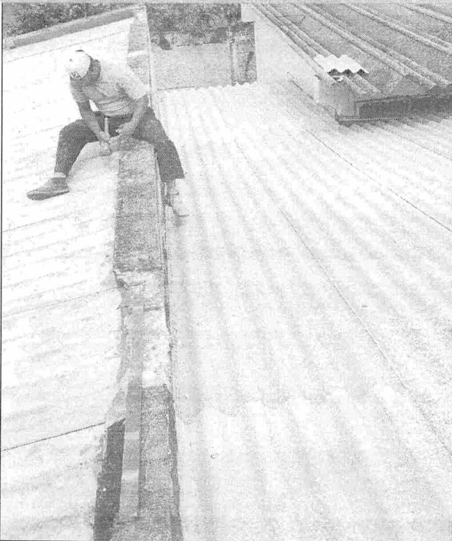
DEMOLIÇÃO DE ARGAMASSA
