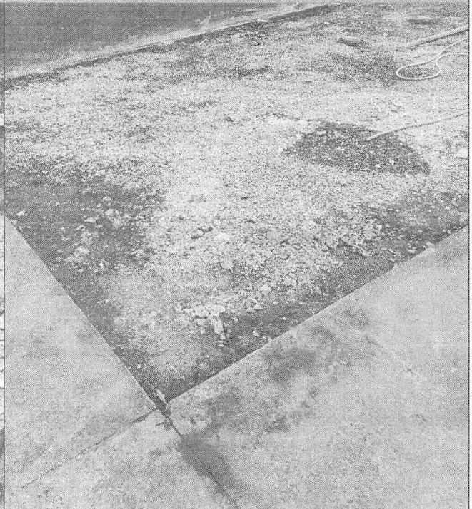
DEMOLIÇÃO PARCIAL DE CONTRAPISO
