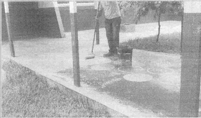
EXECUÇÃO DE PINTURA
