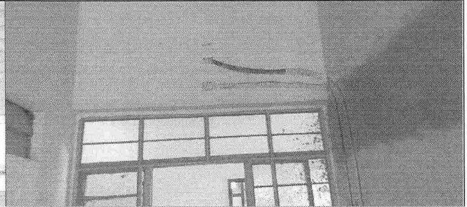
EXECUÇÃO DE PONTOS ELÉTRICOS
