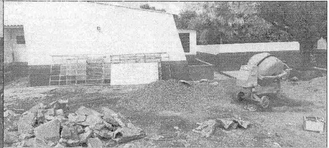
DEMOLIÇÃO PARCIAL DE PÁTIO INTERNO
