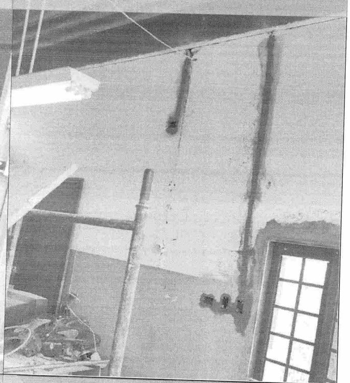
EXECUÇÃO DE PONTOS ELÉTRICOS
