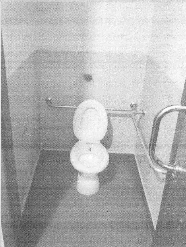
INSTALAÇÃO DE BARRAS PNE
