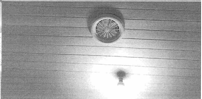
INSTALAÇÃO DE EXAUSTOR
