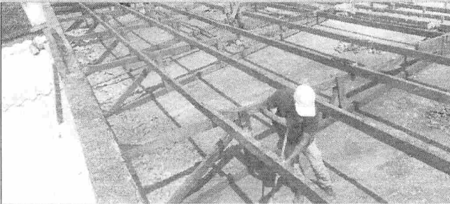
REMOÇÃO DE TELHAS FIBROCIMENTO
