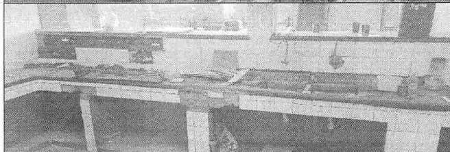
EXECUÇÃO DE PONTOS ELÉTRICOS
