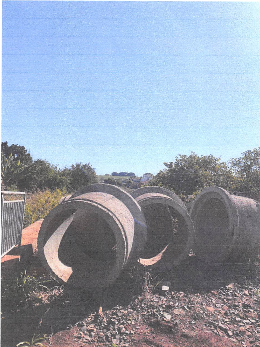
Figura 04 – Tubos de concreto 1200MM sem assentar;
