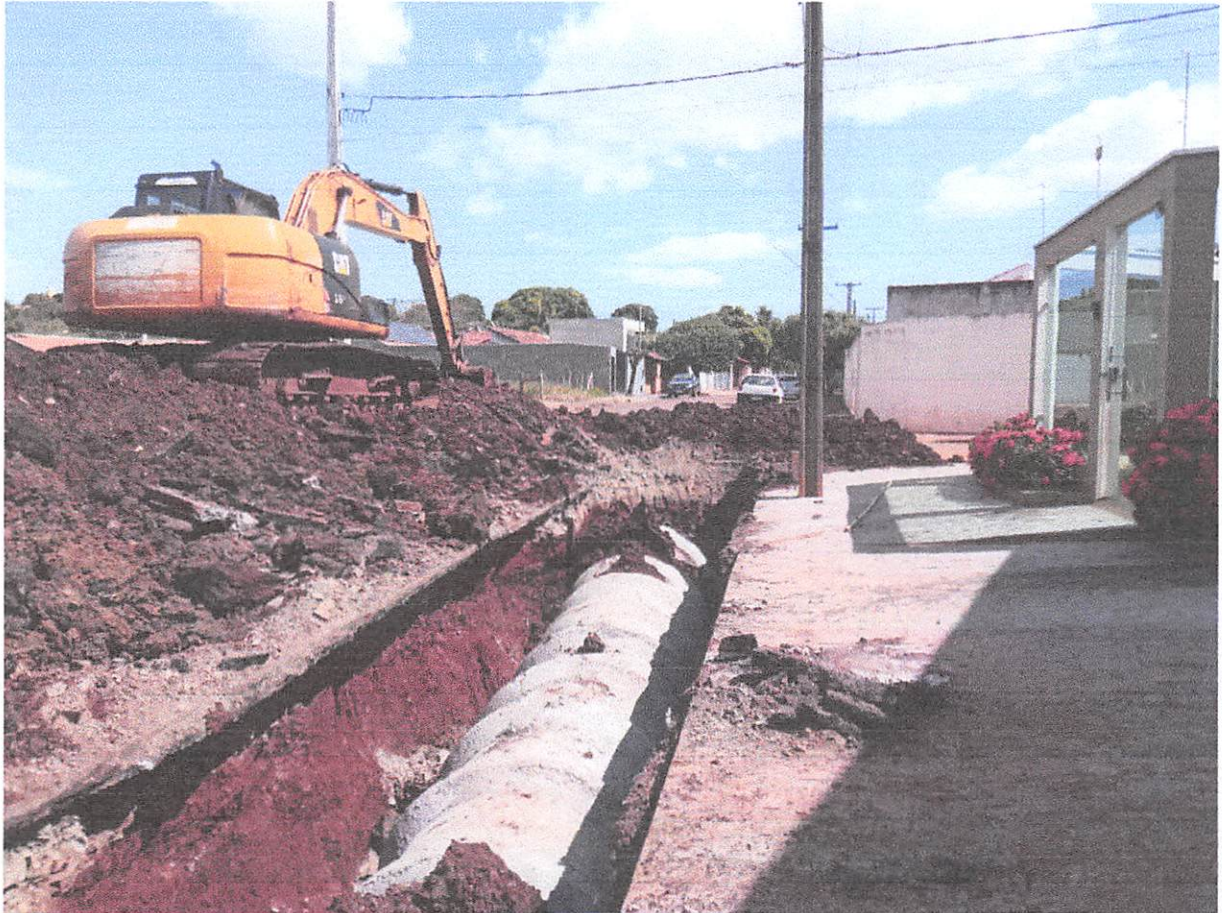
Figura 03 – Assentamento dos tubos de 1200MM;
