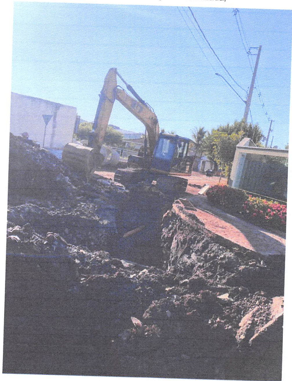
Figura 07 – Escavação Mecanizada;
