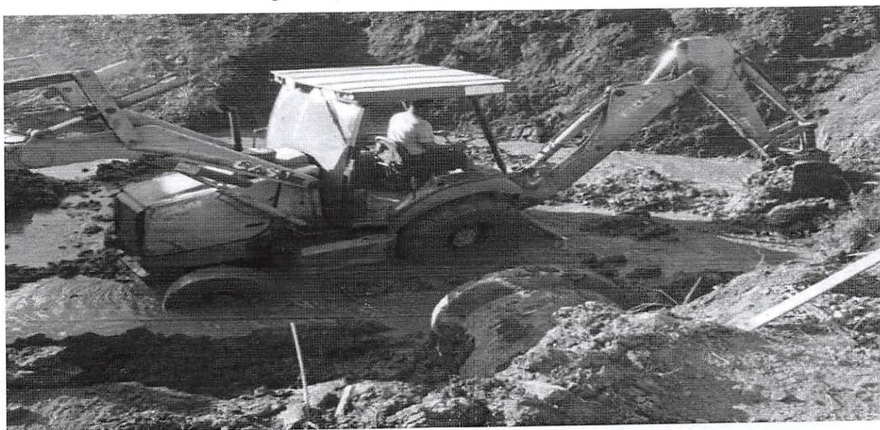
Imagem: Escavação com máquina material brejoso
