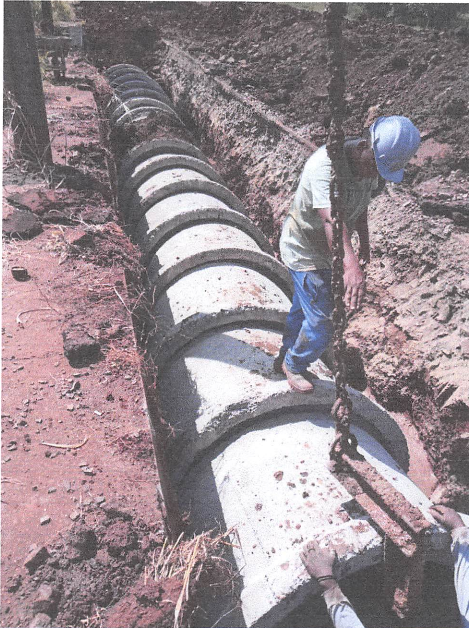
Figura 02 – Assentamento dos tubos de 1200MM;
