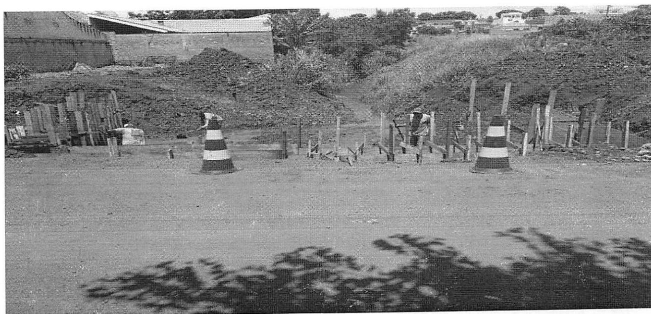
Imagem: Limpeza manual do material brejoso
