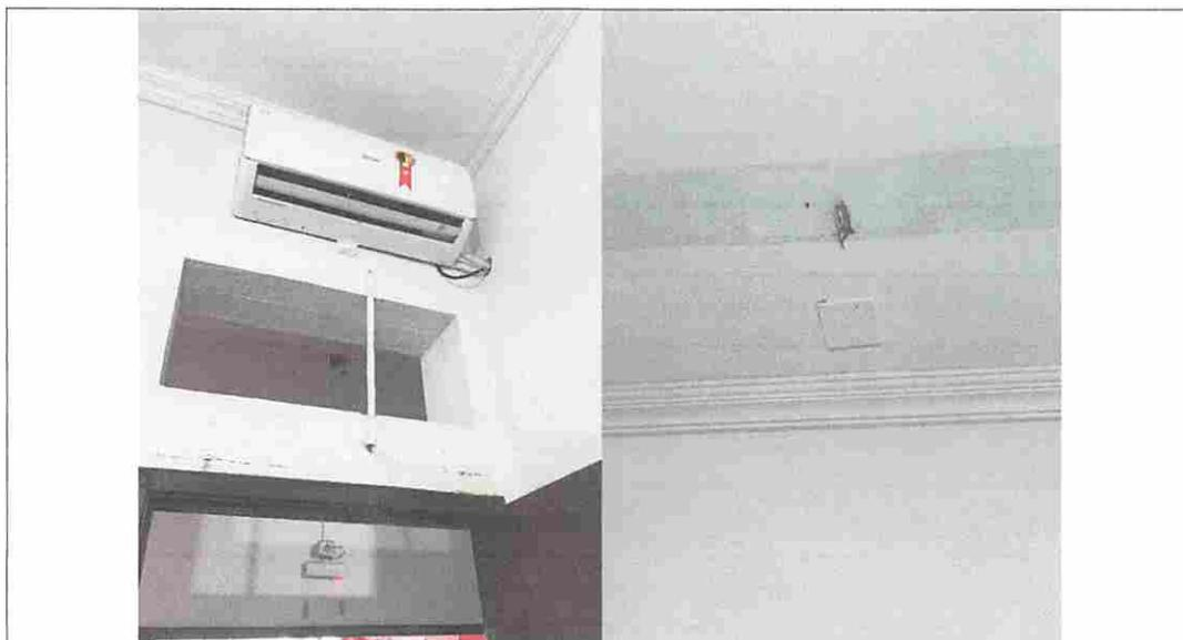
Descrição: A superfície apresenta descascamento localizado da pintura em algumas áreas. Além disso, há uma abertura remanescente no local, necessitando de vedação adequada. Observa-se também a presença de um condutor elétrico exposto saindo do teto, o que representa um risco elétrico.
