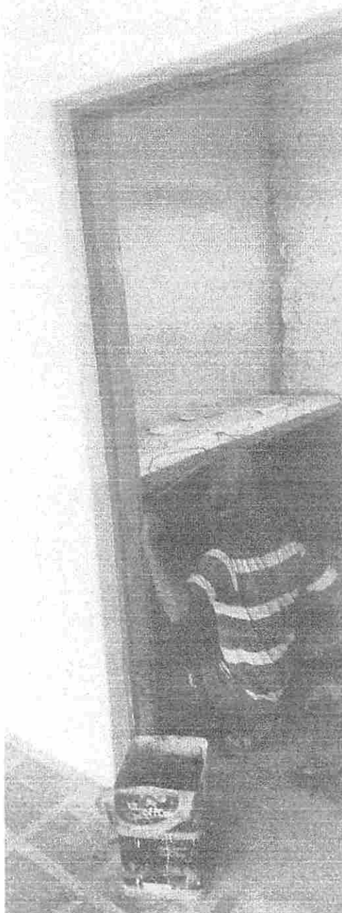
Figura 15 – Execução de cuba para troca de roupa
