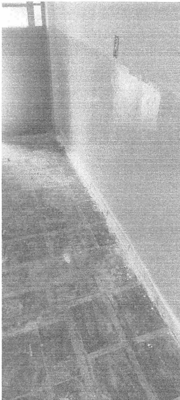
Figura 05 – Pintura das paredes internas e assentamento de rodapés
