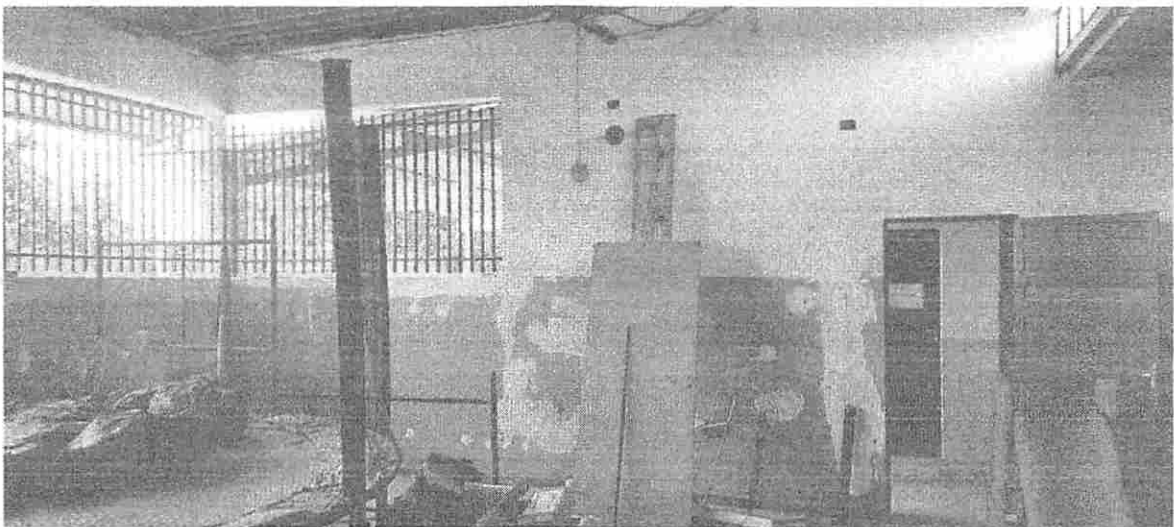
Figura 23 – Instalação de pontos elétricos
